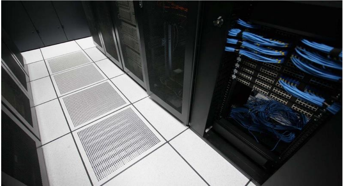
Hình 3-1: Hệ thống sàn nâng
