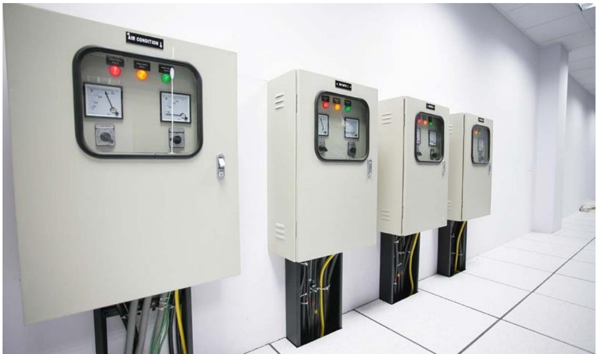
Hình 4-4: Hệ thống PDU cho dây rack
